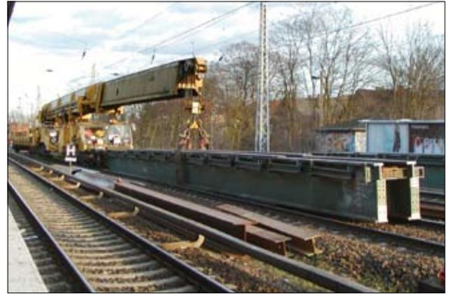
Zwillingsträger-Hilfsbrücke ZH 26: Aus zweimal zwei dieser 26,9 Meter langen Trägern besteht so ein Brückenprovisorium
