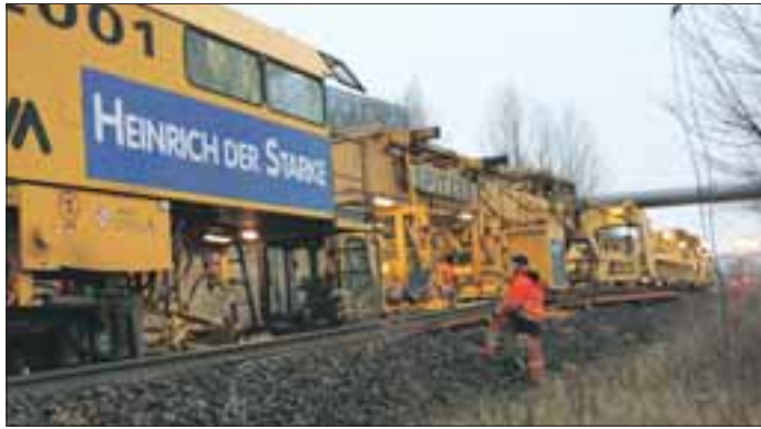
Samstagsmorgen zwischen Lichtenberg und Friedrichsfelde Ost: „Heinrich der Starke“ greift die alten Schienen (grau) und verlegt gleichzeitig die neuen (braun).
